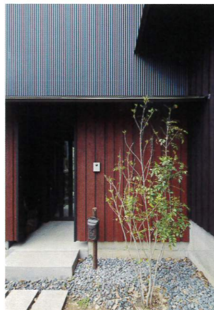
[新築] 外壁:赤べんがら(正面)、黒べんがら(右側) 2階のガルバリウム鋼板との対比
