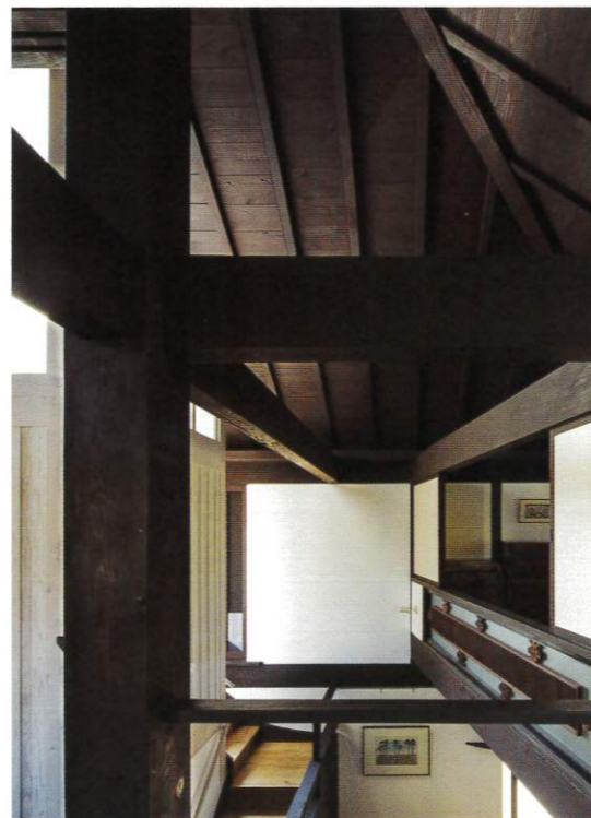
[新築] 柱・梁・天井:黒べんがら
