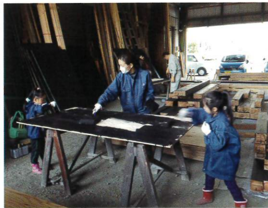
建築主の親子でべんがらの塗装中。 新築の場合の塗装部位は、屋根の化粧野地板、梁組、垂木、2階床組み根太天井、一部壁大和張り、フラッシュ戸、ポイントの柱、それに外壁大和張りなど、塗装面積はかなり広い。
