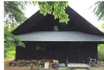
[新築] 1階 外壁・大和張り:黒べんがら 2階 外部・破風:黒べんがら
